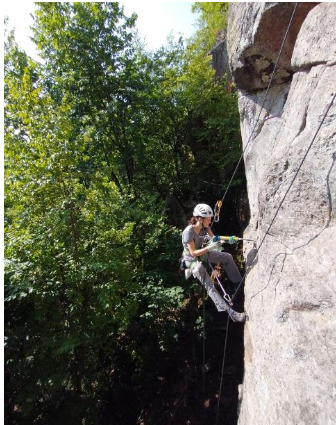
Travail en paroi à Bowman, Outaouais
