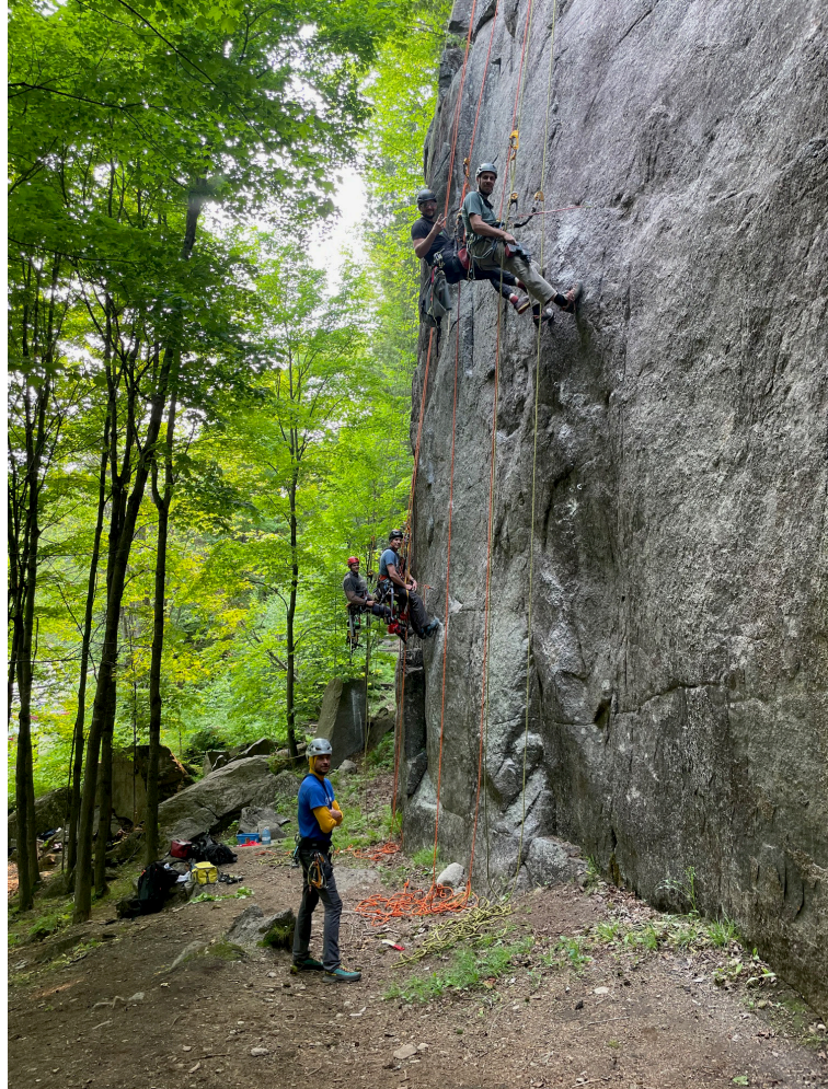
Travaux à Julien Labedan, Crédit photo : Véronique Tessier
