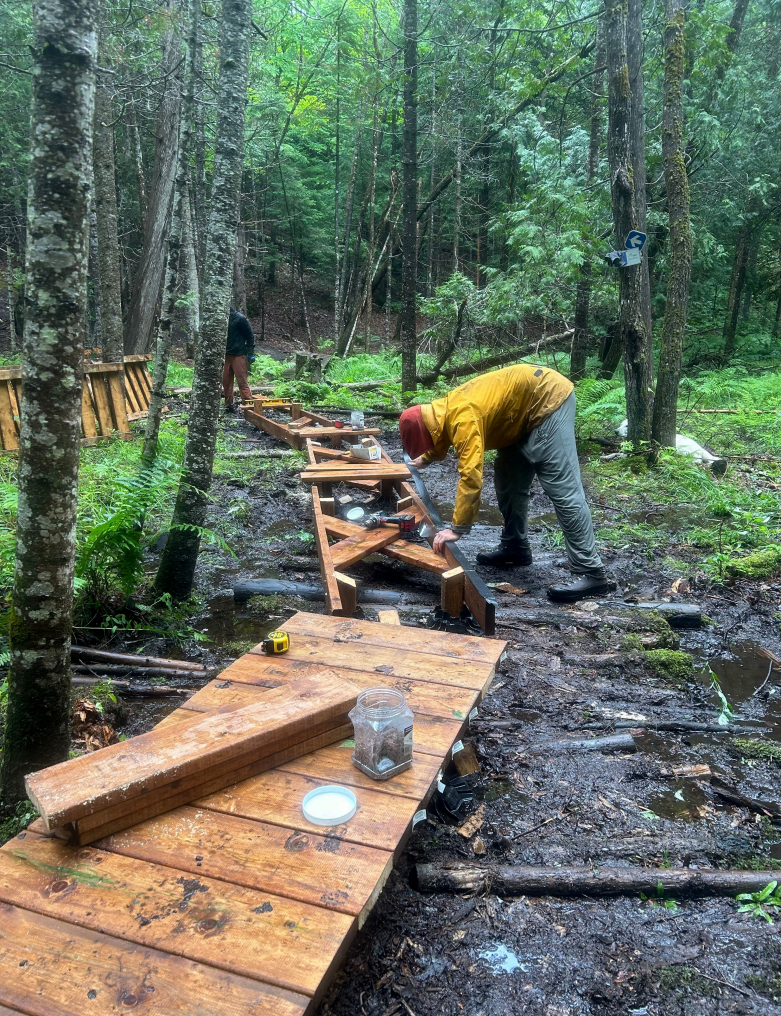
Reconstruction du pont à Baldy, Crédit photo : Sandrine Daoust
